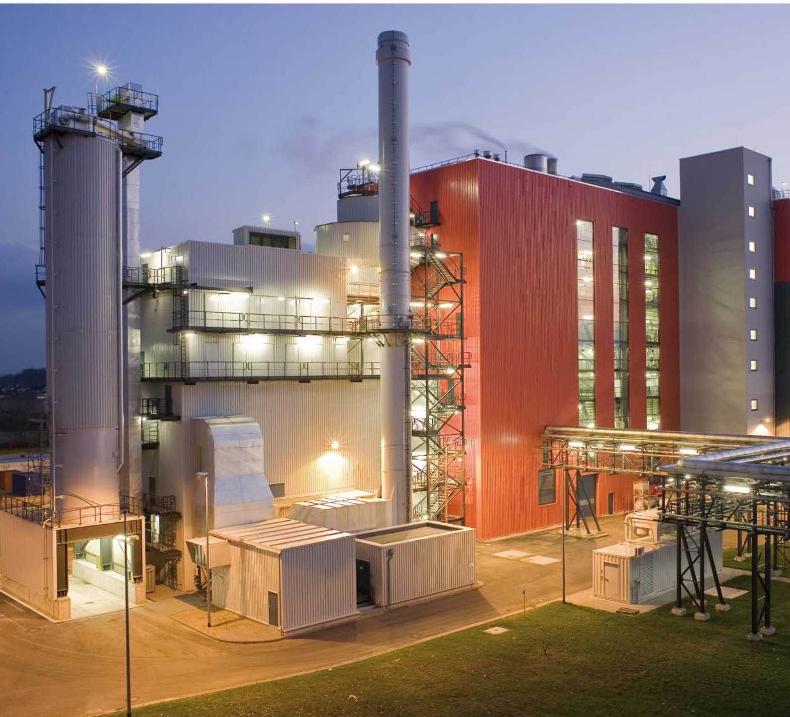
Spezialist in der Entwicklung und im Bau von Anlagen zur Luftreinhaltung – EBS-Verbrennung
